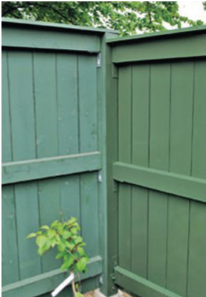
Eerste en tweede laag. Minimaal twee en bij voorkeur drie volledig dekkende lagen.
