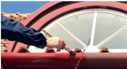
Het is mogelijk om in de volle zon te schilderen, op een schoon oppervlak. Min. temperatuur 15°C. Voorkom condens.
