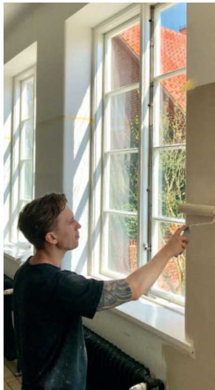
Vul gaatjes en haarscheurtjes met dikke Linus Muurverf, eventueel steviger gemaakt met puimsteenpoeder. Verspreid deze plamuur over het hele oppervlak met bijvoorbeeld een roller.
