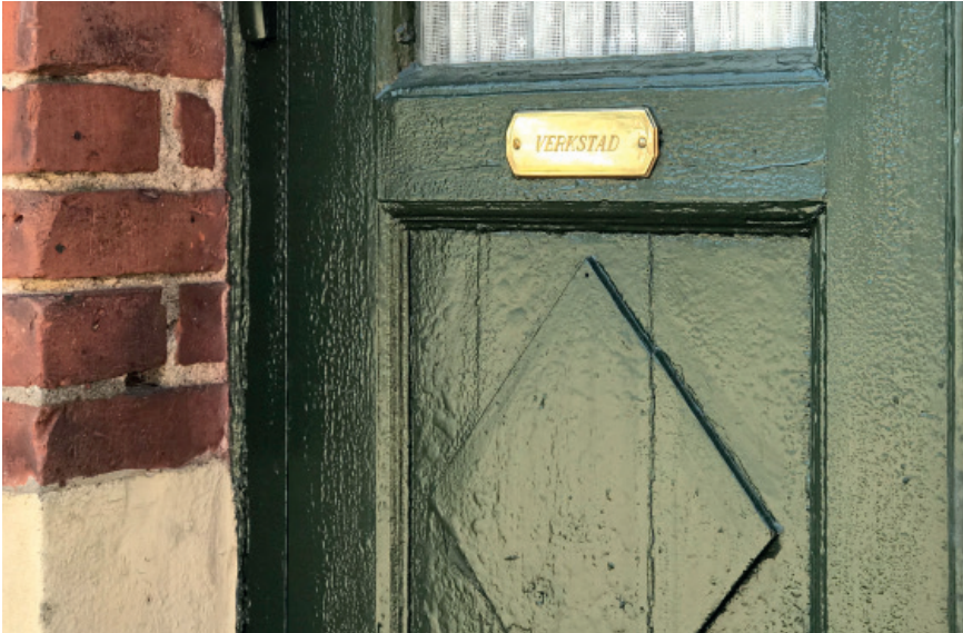
Deur uit 1926. Een eenvoudige anti-verouderings maatregel na 100 jaar. Vul scheuren met lijnoliestopverf en schilder het oude oppervlak met een nieuwe laag lijnolieverf.
