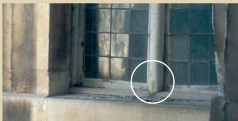
In de cirkel - Originele lijnolievert uit het jaar 1680 op de ramen van het Château de Versailles, Frankrijk.
