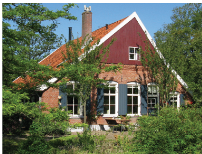
Boerderij de Stegge, Winterswijk-Kotten, sinds 2010 onderhouden met Allbäck lijnolieverf.
