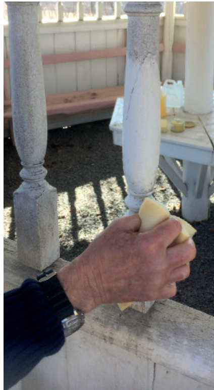
Reinig ongeverfde en geverfde oppervlakken grondig voordat u gaat schilderen.
