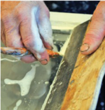
Haal met een glaskrabber en een beetje verdunde lijnoliezeep de verf 2mm vanaf de stopverfrand weg.
