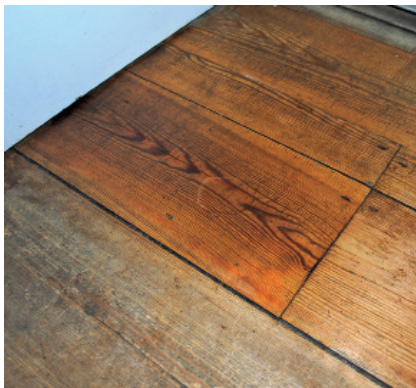
Allbäck lijnoliewax transparant op een oude vloer, voor en na de behandeling.
