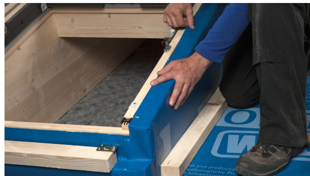
22. Verlijm SOLITEX WELDANO 3000 op de zijkant van het kozijn. Leg de folie met een uitzettingslus in de lijmlaag. Druk de lijm daarbij niet helemaal plat, zodat bewegingen kunnen worden opgevangen.
