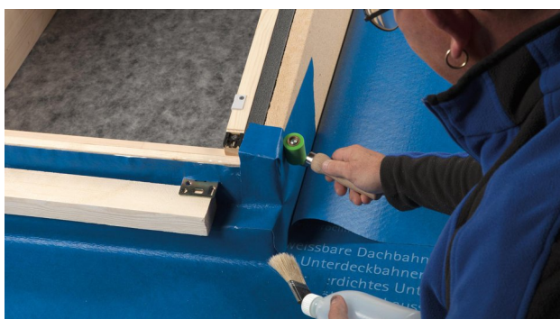
15. Vouw opstaande randen om en las deze aan de onderliggende folie vast. Zorg daarbij dat de hoeken goed zijn afgedicht.
