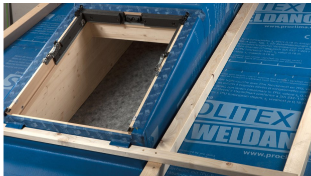
34. Monteer de tengellatten en steunlatten en schroef de montagehoeken vast. Klaar.
