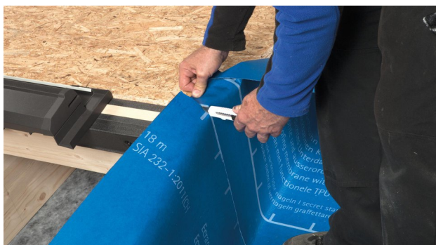
17. Leg de folie tegen de zijkant van het dakraam omhoog. Alternatief kan er ook een nieuwe strook SOLITEX WELDANO 3000 op maat worden gesneden en tegen de zijkant van het dakraam worden gelegd. Deze wordt dan op de onderliggende strook gelast.
