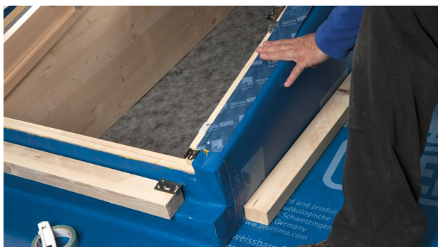
23. Gebruik TESCON VANA om alles te fixeren.
