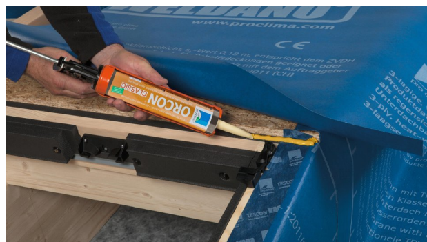
24. Verlijm SOLITEX WELDANO 3000 met ORCON CLASSIC op de bovenste rand van het kozijn.
