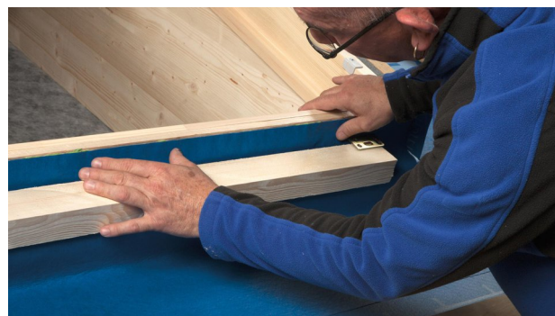
8. Leg SOLITEX WELDANO-S 3000 met een uitzettingslus in de lijmlaag. Druk de lijm daarbij niet helemaal plat, zodat bewegingen kunnen worden opgevangen.
