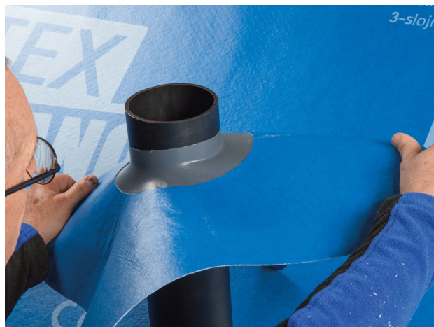
2. Aansluiting realiseren Breng WELDANO ROFLEX PLUS aan rondom de buis.
