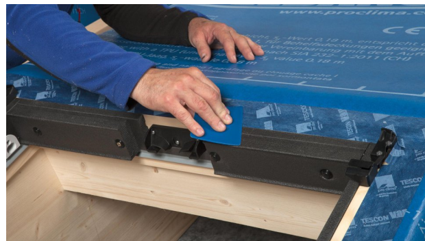
26. Gebruik TESCON VANA om alles te fixeren.
