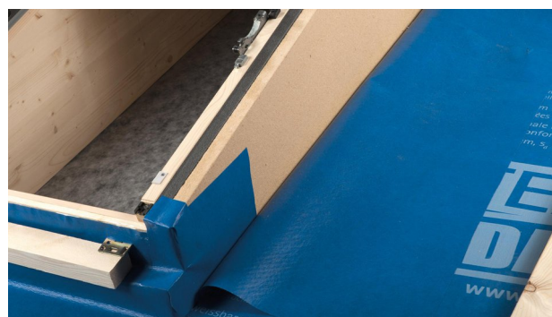
16. De onderste hoek is nu afgedicht.
