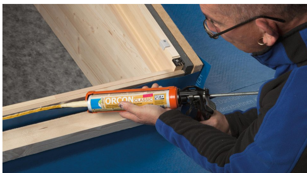
7. Breng een rups ORCON CLASSIC van minimaal 6 mm doorsnede aan op de minerale ondergrond (bij ruwe ondergronden eventueel meer) en verlijm het stuk SOLITEX WELDANO-S 3000 op de onderzijde van het kozijn.
