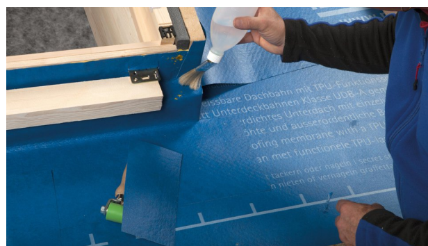
12. Las het stuk bij de hoek aan de onderrand van het kozijn/isolatieframe vast.
